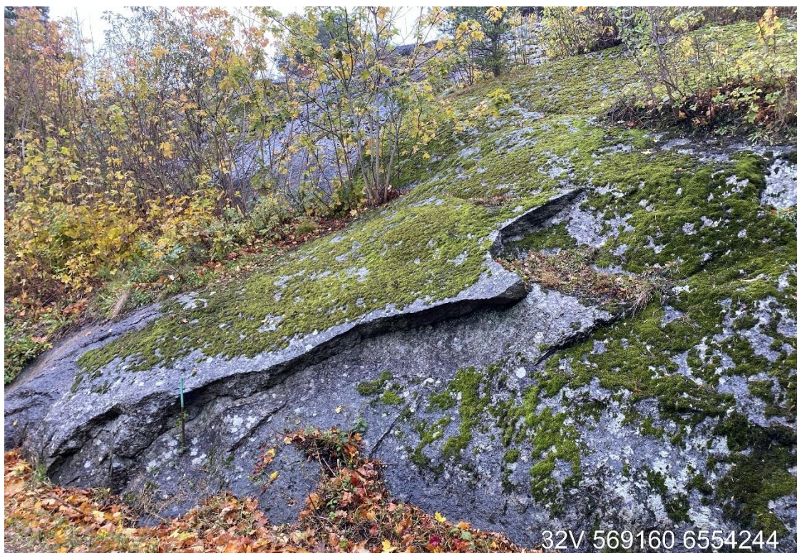
Figur 5: Svaberg ved planlagt bergskjæring B1. Utgående sprekkeplan.
