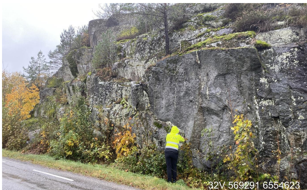
Figur 7: Eksisterende bergskrent/bergskjæring vest for Haneholmveien i nord (Viriklia). Synlige borpiper og noe grovblokkig berg.
